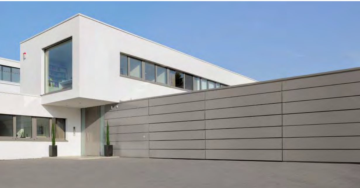
Bauseitige Beplankung mit Aluminium-Verbundplatten
