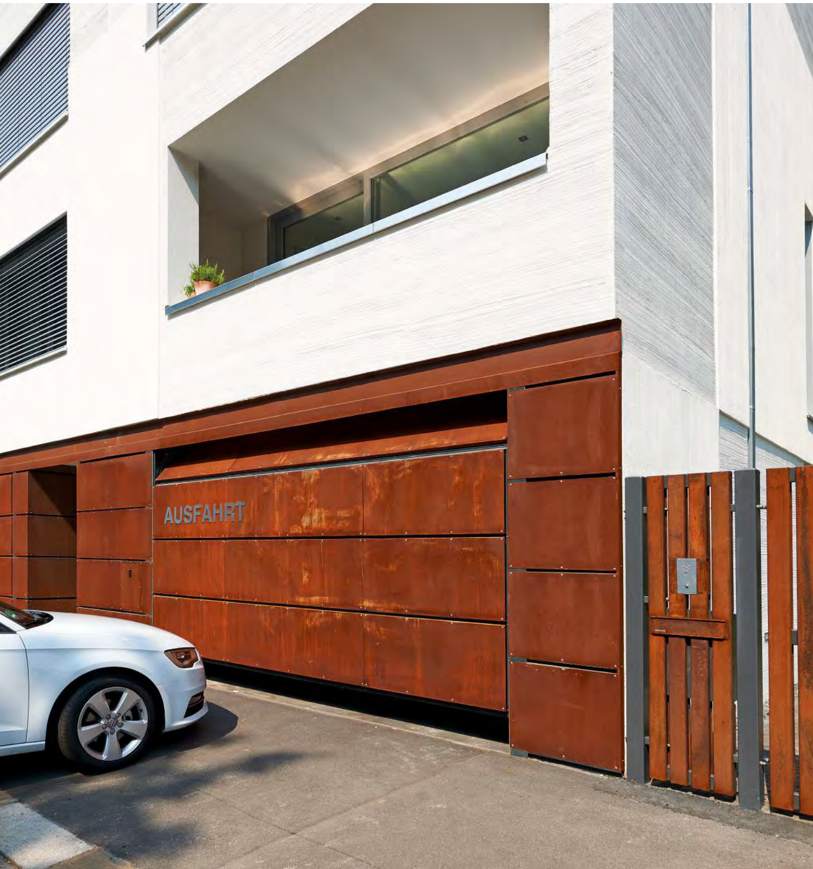
Bauseitige Beplankung mit Schichtpressplatten
